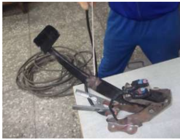
圖12 焊接踏板彎曲截斷部位焊接
